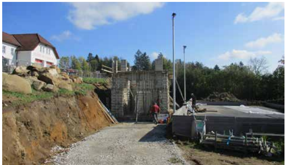
Schalungsarbeiten - Das neue Splittlager entsteht unterhalb des FF-Hauses in Piberschlag
